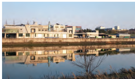
남동구 음식물류폐기물 공공처리시설
