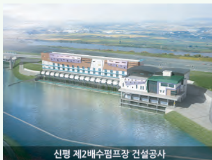
신평 제2배수펌프장 건설공사
