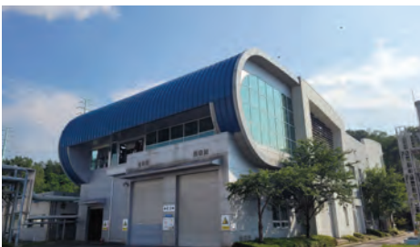
원주시 하수슬러지 처리시설
